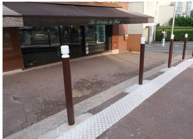
En 2022, un aménagement complet a été réalisé pour la mise en accessibilité de la Boulangerie du Cours des Lacs (potelets et bandes podotactiles).
