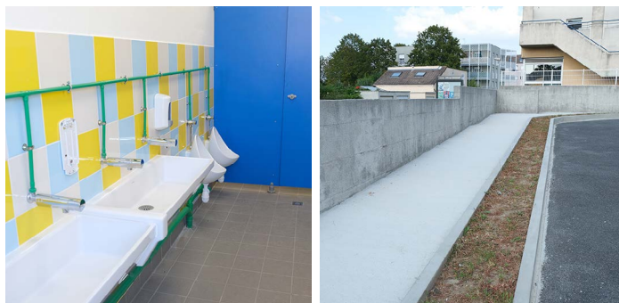
Réfection des sanitaires et création d'une rampe d'accessibilité au groupe scolaire du Mandinet
