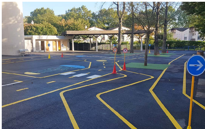
Création d'une piste cyclable de sécurité routière à la Maillière
