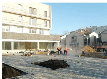
Création d'une placette végétale
