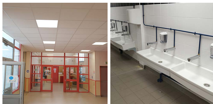
Rénovation des éclairages et des sanitaires au groupe scolaire Le Four
