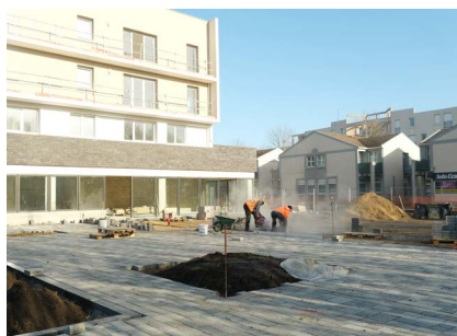
Création d'une placette végétale
