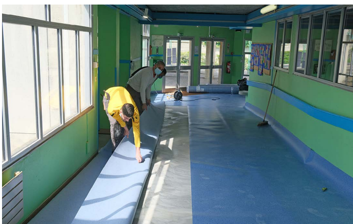
Réfection des sols au groupe scolaire du Village
