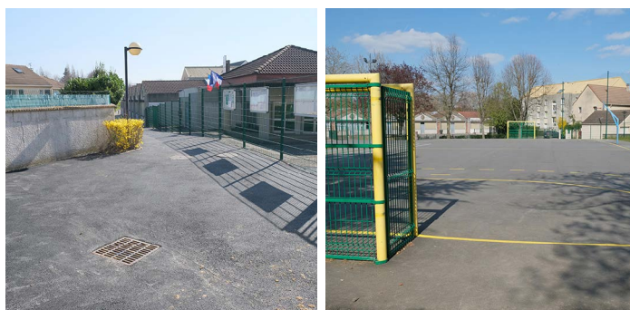
Rénovation du cheminement piéton et du plateau EPS à l'école du Village
