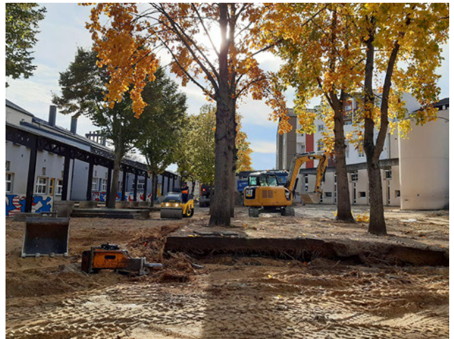
Travaux en cours à la Maillière
