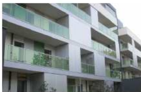
des celliers extérieurs rythment la façade, séparent deux balcons / loggias et permettent un rangement extérieur
