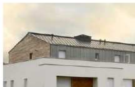
les installations techniques bien intégrées dans le volume construit du dernier niveau: INSTALLATION EXEMPLAIRE
