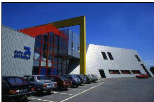
Centre de distribution de la SEITA
