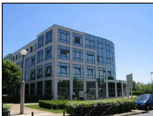
Immeuble d'activité Le Newton
