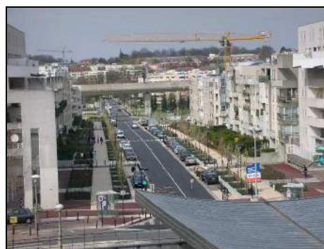
Aménagement du boulevard Camille Saint-Saëns
