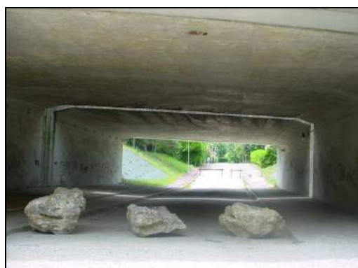
Passage souterrain sous la VPO, entre la rue du Bois de la Grange et le bois de Lognes
